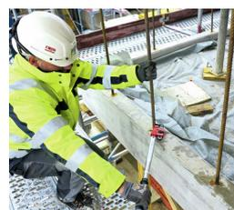
Gracias a los alicates de una mano Stillson, la llave dinamométrica es ideal para geometrías redondas, ovaladas y angulares que quedan fuera de las normas DIN comunes. La tuerca de ajuste endurecida con el muelle evita el ajuste involuntario y garantiza la máxima autofijación. Especialmente adecuado en el sector de la construcción para los ferrallistas y los constructores de hormigón armado, así como en la ingeniería
