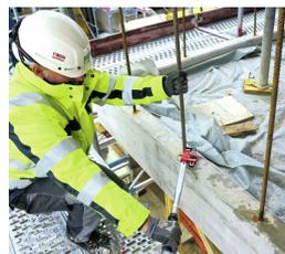
Drehmomenteinstellung von 40-210 Nm, Spannbereich 5-40 mm
